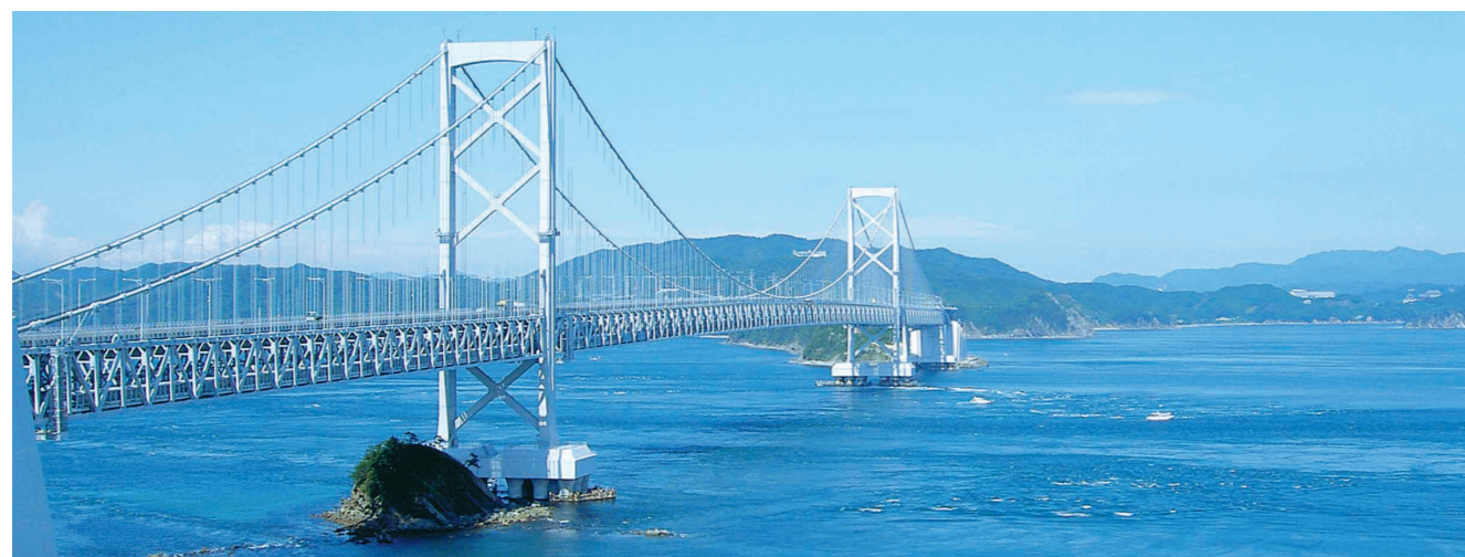
大鳴門橋 Great Naruto Bridge
